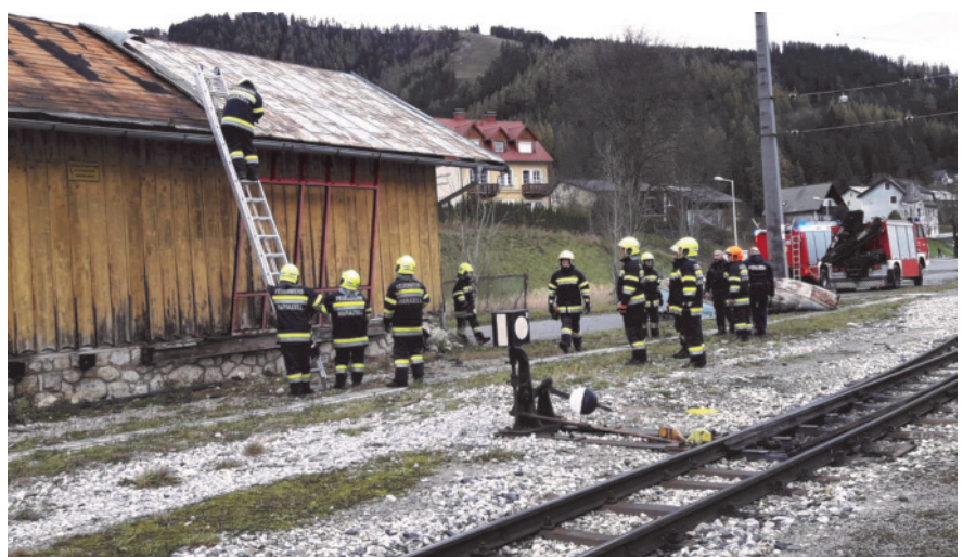
Sturmschaden im Bahnhofsbereich von Mariazell
